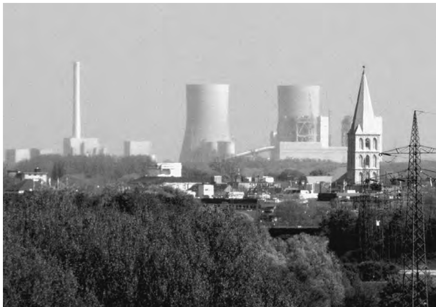
Soll nun doch erst im Mai 2014 den Betrieb aufnehmen: Das Kohlekraftwerk Westfalen in Uentrop.
